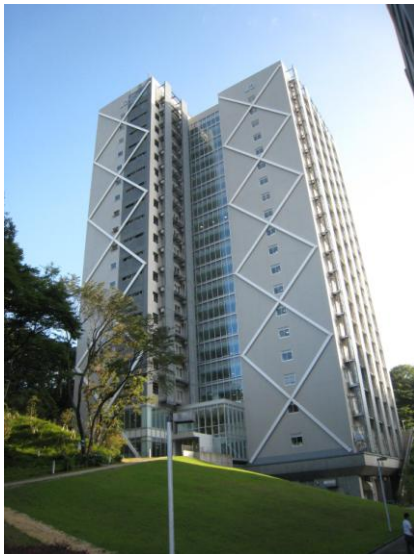
地震・風観測を行っている超高層免震建物 (すずかけ台キャンパス) High-rise Isolated Building in Suzukakedai Campus
