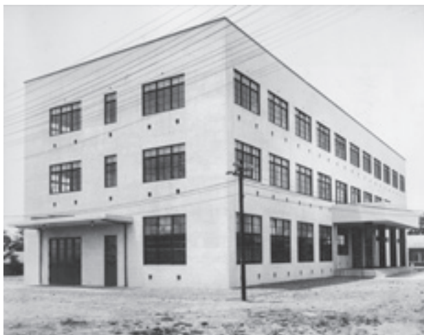
写真1 新設された建築材料研究所（昭和8年6月）
