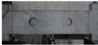
せん断破壊した貫通孔のあるRC梁
