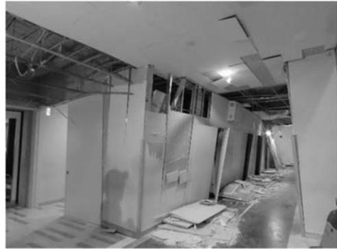
図1 LGS 壁の地震被害の一例<sup>1)</sup>
