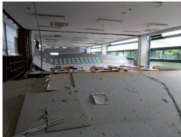
写真1 校舎の教室を構成するLGS間仕切り壁の地震被害である。間仕切り壁が構造骨組から外れ、甚大な被害を引き起こしている。もし子供達が授業を受けていたらと思うと、ゾッとする光景である。
