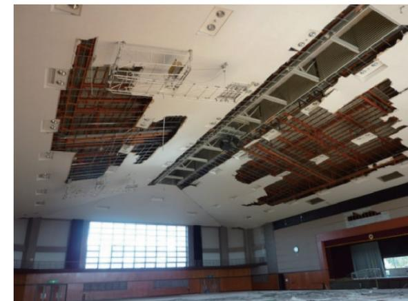
写真1 天井の脱落被害の例(東日本大震災)
