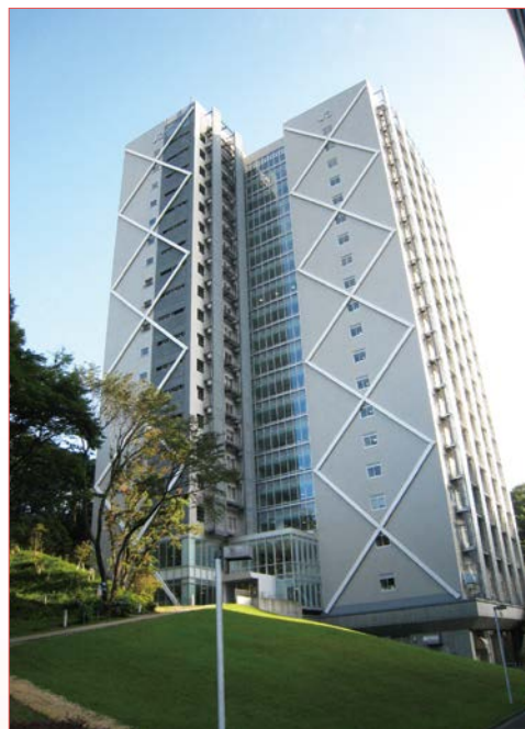
地震・風観測および応答評価を行っている超高層免震建物 (すずかけ台キャンパス)
