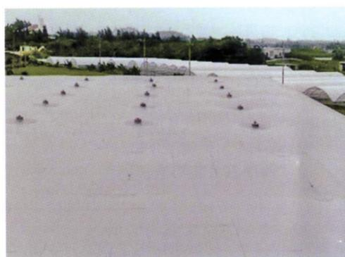
台風時の強風による防水層の吸い上がり現象
