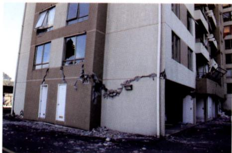
現地では完全に倒壊した建物や甚大な被害により建て替えを余儀なくされた建物等の多数の被害建物の調査を行った。地震の規模を考慮すると鉄筋コンクリート造建物の被害は小さかったと考えられるが、被害を受けた鉄筋コンクリート造壁式構造の建物では、曲げによる耐震壁低層部、耐震壁をつなぐスラブや階段などに特徴的な破壊性状が観察された。調査の資料を基に、今後はモデル解析等で分析していく予定であり、日本の鉄筋コンクリート造建物の耐震設計にも影響を及ぼす結果が得られると考えられる。
