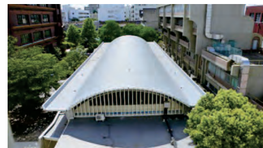
ある鉄筋コンクリート円筒形シェル
