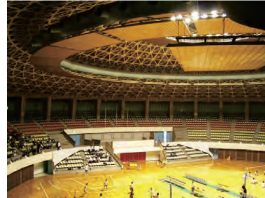
ある鉄骨円錐形シェル (内部)
