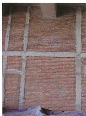
レンガ造による間仕切壁
