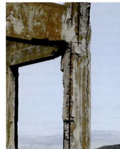
湾岸コンクリート造建物の劣化
