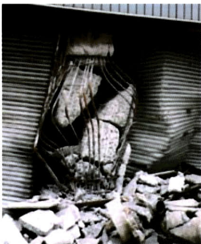
阪神・淡路大震災で実際に起きた柱のせん断破壊
