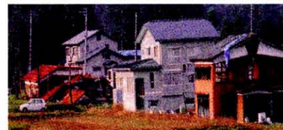
■木造戸建住宅の被害(2004年新潟中越地震)
