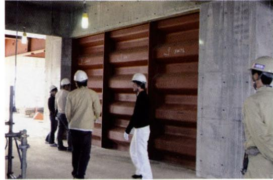
新築建物に使用された波形鋼板
