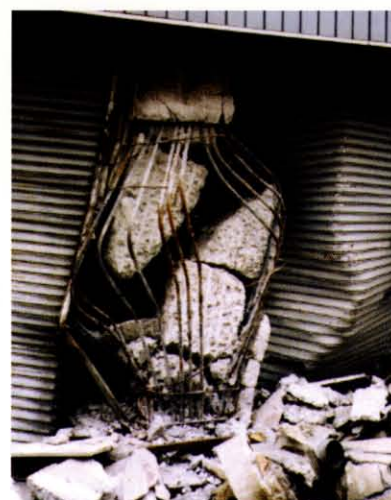
阪神・淡路大震災で実際に起きた柱のせん断破壊
