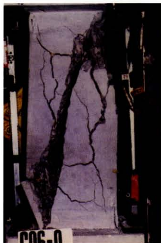
実験で再現した柱のせん断破壊
