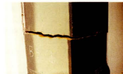
兵庫県南部地震における鋼構造建築の被害 (上は梁端の破断、下は厚肉柱の脆性破壊)
