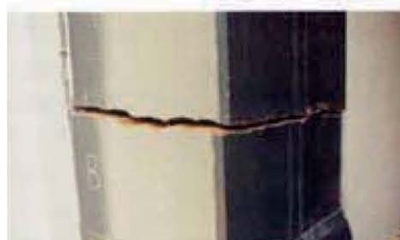
兵庫県南部地震における鋼構造建築の被害 (上は梁端の破断、下は厚肉柱の脆性破壊) Brittle Fracture in Kobe Earthquake
