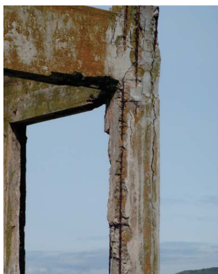
湾岸コンクリート造建物の劣化
