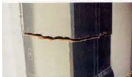
兵庫県南部地震における鋼構造建築の被害 (上は梁端の破断、下は厚肉柱の脆性破壊) Brittle Fracture in Kobe Earthquake
