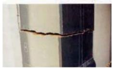
兵庫県南部地震における銅構造建築の被害 (上は梁端の破断、下は厚肉柱の脆性破壊) Brittle Fracture in Kobe Earthquake
