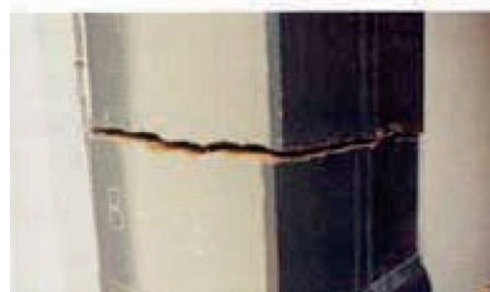
兵庫県南部地震における鋼構造建築の被害 (上は梁端の破断、下は厚肉柱の脆性破壊) Brittle Fracture in steel members under Kobe Earthquake
