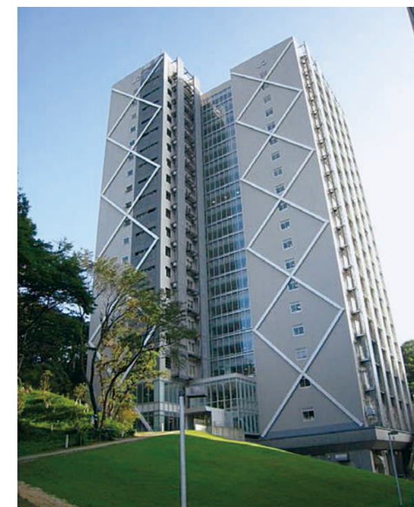
地震・風観測を行っている超高層免震建物（すずかけ台キャンパス） High-rise Isolated Building where Earthquake and Wind Observation are Carried out in Suzukakedai Campus
