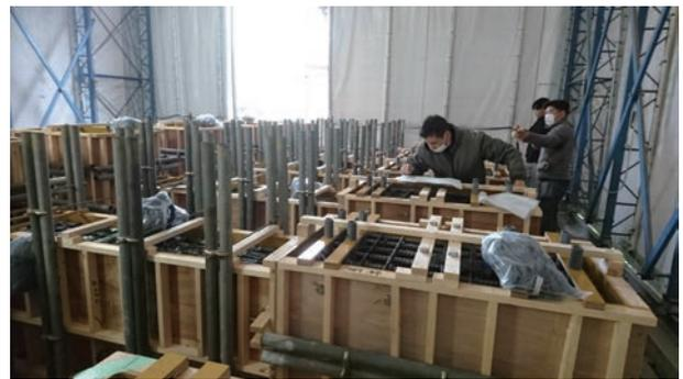
RC試験体のコンクリート打設を前に、配筋検査を行っている様子
